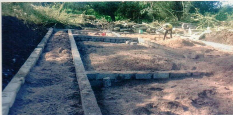
Kein Sandkasten – hier entsteht die Apotheke beim Wasso Hospital in Tansania.
